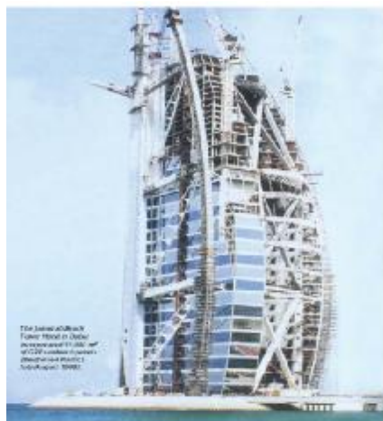
Slika 1. Upotreba kompozitnih materijala u građevinarstvu Hotel „Burj Al Arab” u Dubaiju u svojoj konstrukciji sadrži 33000m 2 staklom ojačanih sendvič-panela Figure 1. Use of composite materials in civil engineering Hotel Burj Al Arab at Dubai Its construction consist of 33000m 2 reinforced sandwich panels
